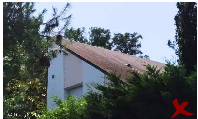
Vue sur une toiture monopente
