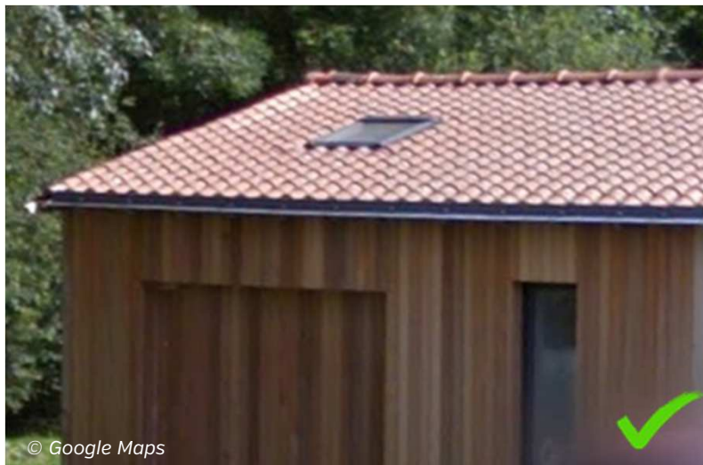
Le percement est aligné
