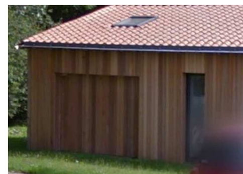
Porte de garage intégrée à la façade
