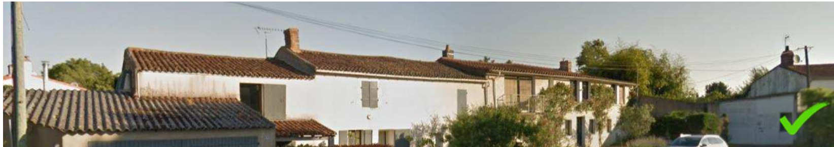
Exemple de rupture de hauteur de faîtage et d'égout
