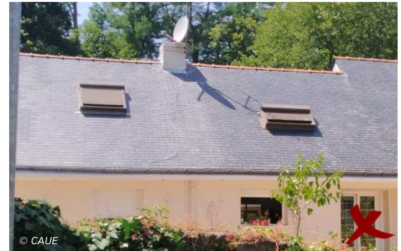
Les percements sont désordonnés
