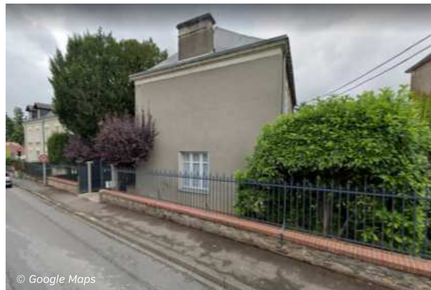
Mur de clôture en moellons de schiste et ferronnerie
