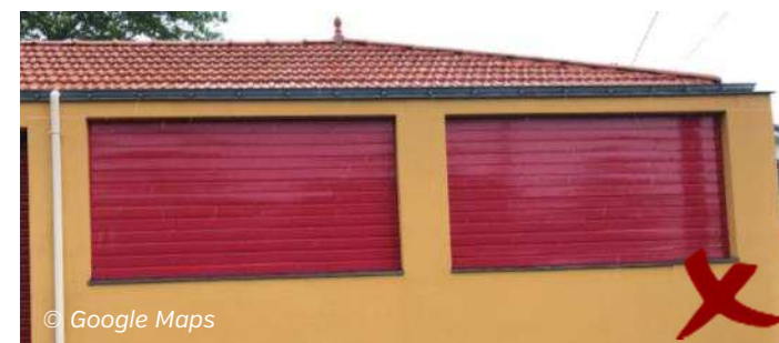
Ouvertures en bandeau sur façade sur rue et façade colorée non adaptées au contexte local.
