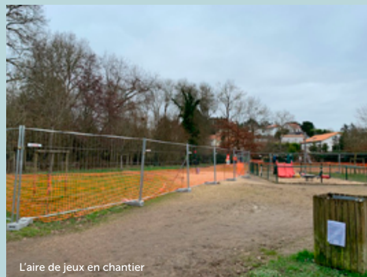
L'aire de jeux en chantier
