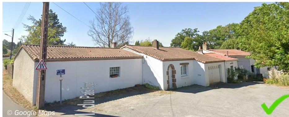
Exemple de rupture de hauteur de faîtage et d'égout
